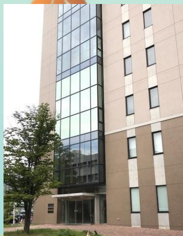
旭総合研究棟外観
